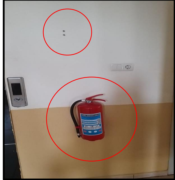
Okul ve kurumlarda yangın tüplerinin montajı öğrenci boy ortalaması düşünülerek montajının yapılması.
