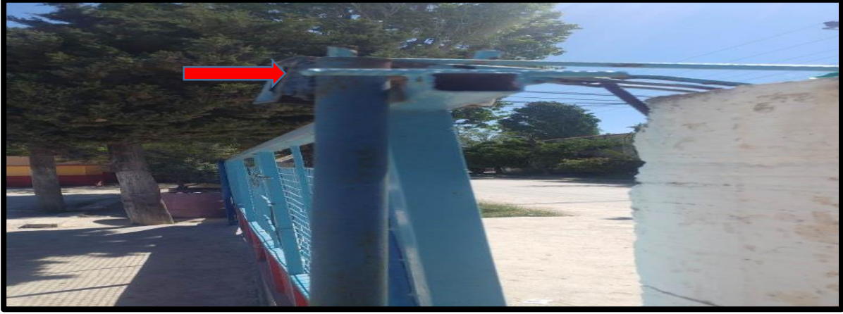
Okul bahçesi sürgülü kapının düşmemesi için aparat yapılmış.
