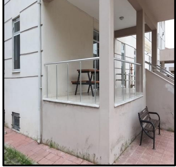
Pansiyon Çıkışı boşluk korkuluk ile düşme önlenmiştir.
