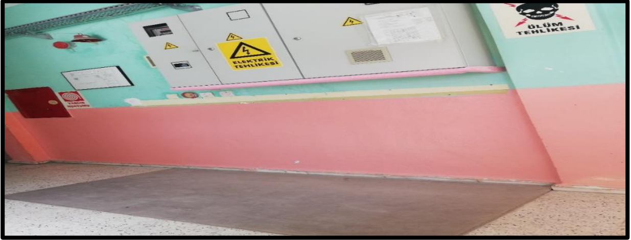
Elektrik panosu önüne elektrik çarpmalarına karşı 1.5 mm kauçuk paspas
