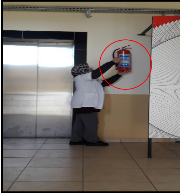
Okul ve kurumlarda yangın tüplerinin montajı öğrenci boy ortalaması düşünülerek montajının yapılması.
